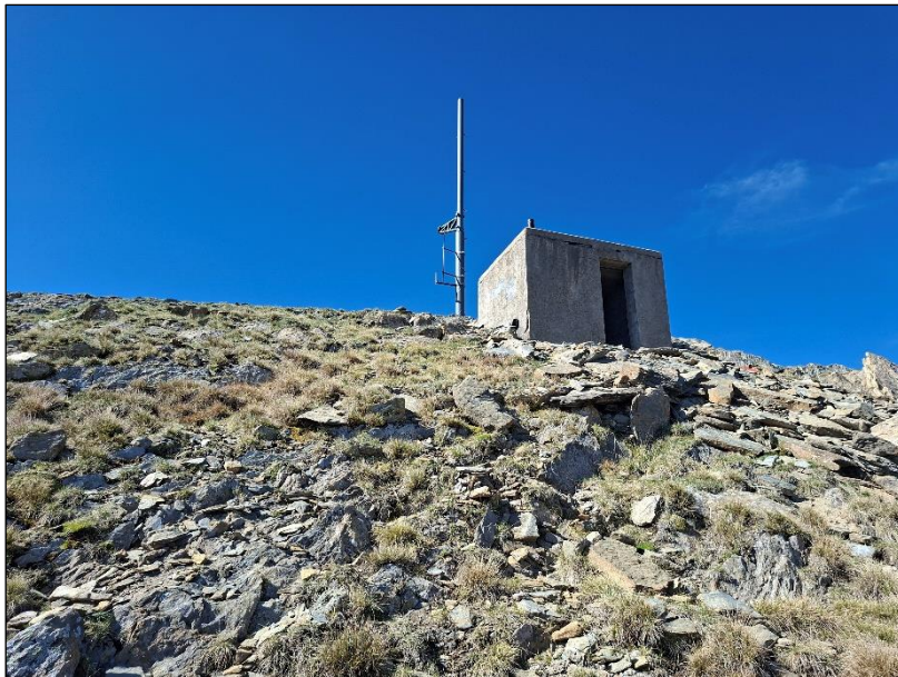
Fotografia 25.- Vista de la caseta i de l'antena (1)
