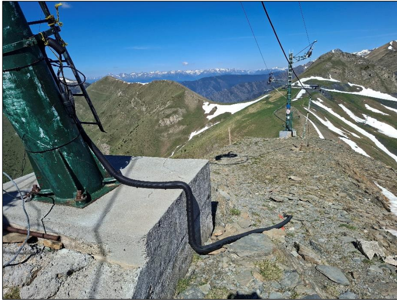
Fotografia 21.- Vista del telesquí de la Capa
